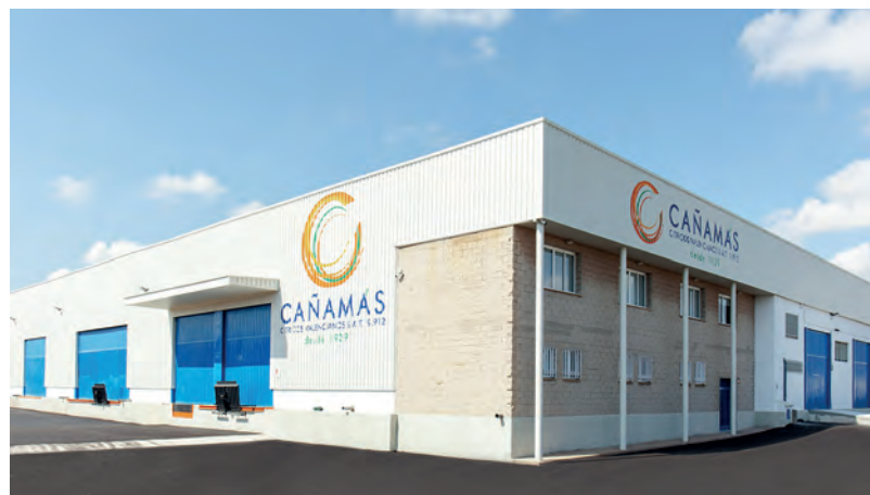
Nuevo almacén de la compañía en Betxí (Castellón). / CAÑAMÁS HERMANOS
