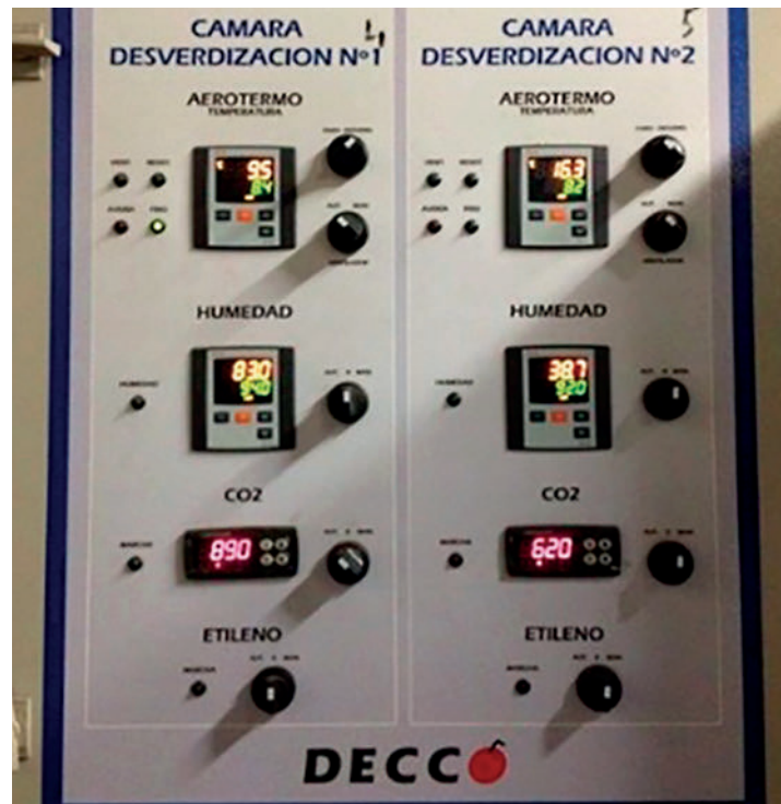
Decco Ibérica dispone del equipo Decontrol, un sistema que aúna varios equipos para acondicionar las máquinas de desverdizado. / DECCO
