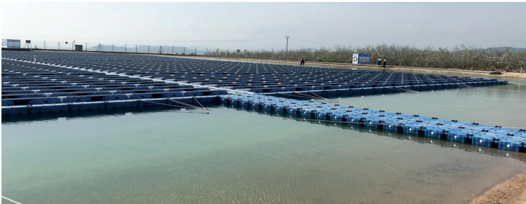
Las placas solares y los flotadores ocupan más de 6.000 m<sup>2</sup> de la balsa de riego, casi la mitad de su superficie.
