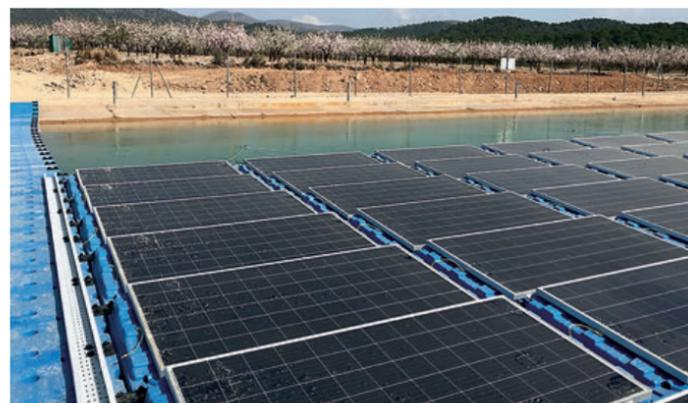
Los flotadores permiten acceder a las placas para supervisión y mantenimiento.
