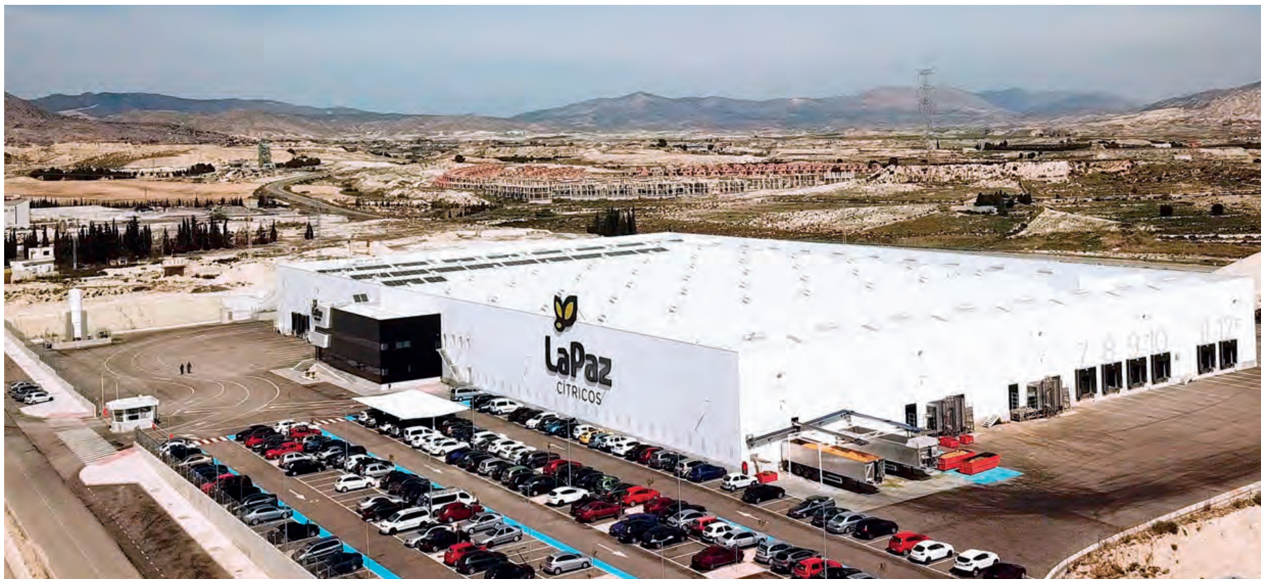
La empresa murciana inauguró sus instalaciones con la más moderna tecnología hace apenas tres años. / IMÁGENES: CÍTRICOS LA PAZ
