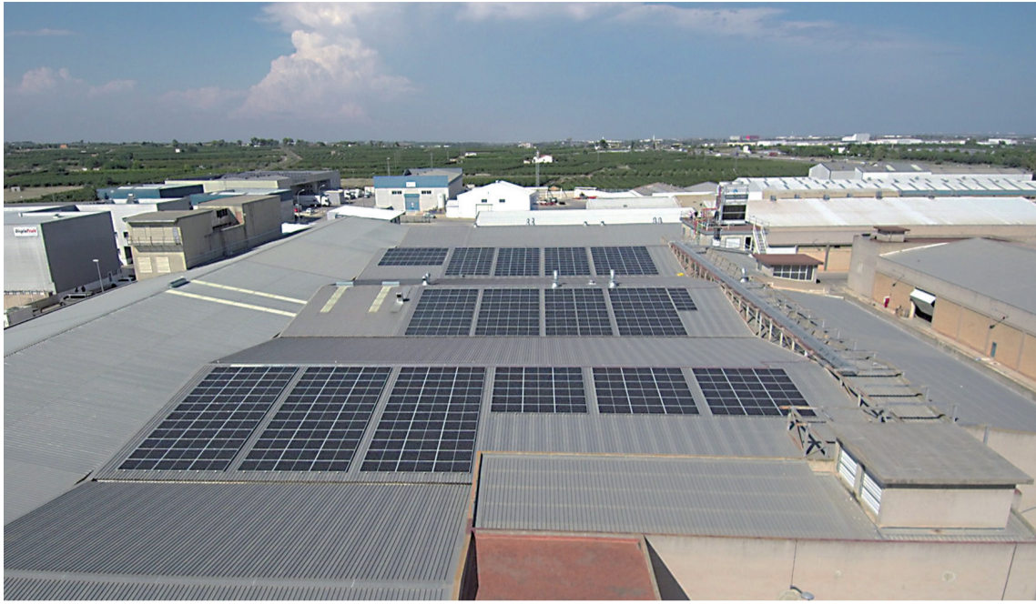
Imagen aérea de la instalación de la planta fotovoltaica que ha instalado la compañía. / DISPLAFRUIT
