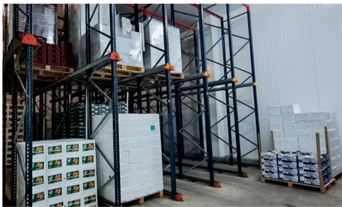
Blasco cuenta con gran superficie de cámaras de frío de última generación. / NR
