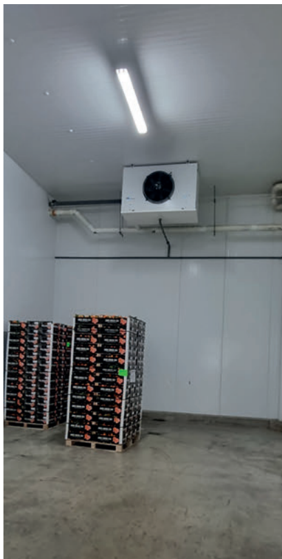
Las cámaras frigoríficas de atmósfera controlada controlan la temperatura, humedad, circulación y renovación de aire. / NR
