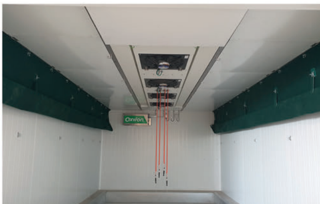
Las cámaras frigoríficas de atmósfera controlada controlan la temperatura, humedad, circulación y renovación de aire. / NR
