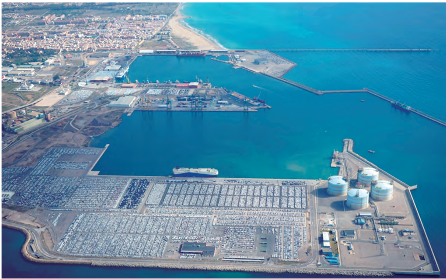
Se están realizando importantes inversiones para garantizar el tráfico de productos perecederos desde los muelles de Valenciaport, en Valencia, Sagunto y Gandía. / GG
