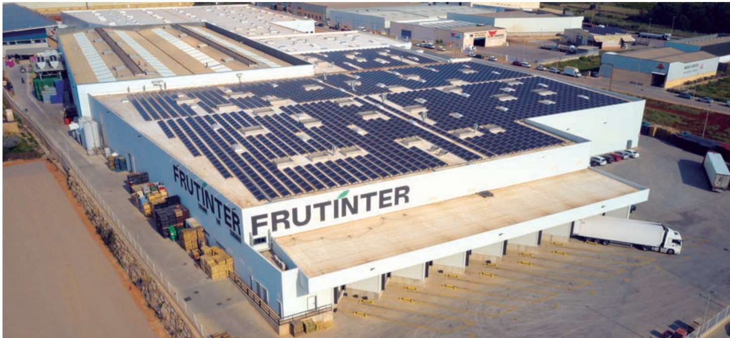
Almacén de Onda acondicionado con placas solares y claraboyas. / FRUTINTER
