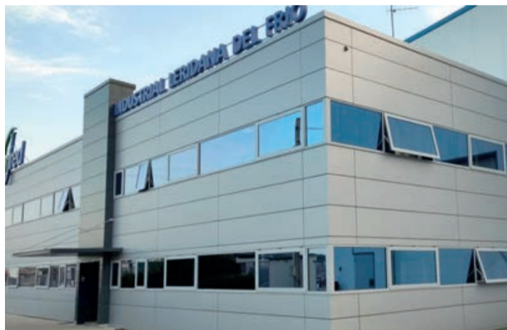
Fachada de las instalaciones de Ilerfred, Industrial Leridana del Frío SLU. / ILERFRED
