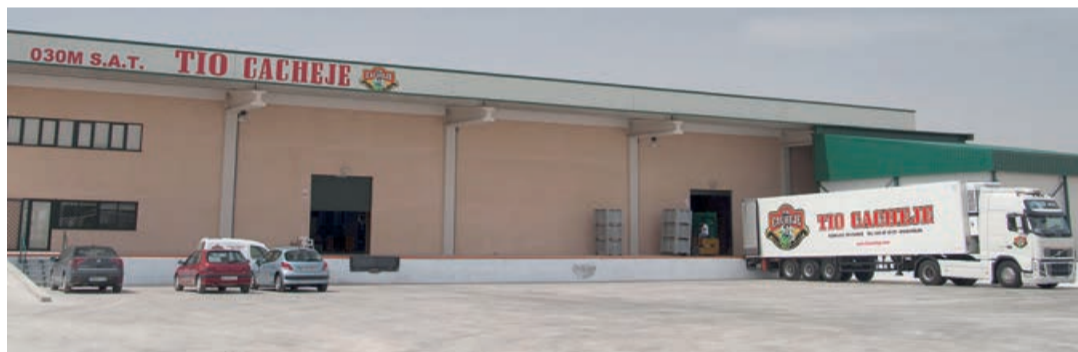
Tío Cacheje cuenta desde el pasado año con placas solares y ha incorporado maquinaria nueva en el almacén. / TÍO CACHEJE
