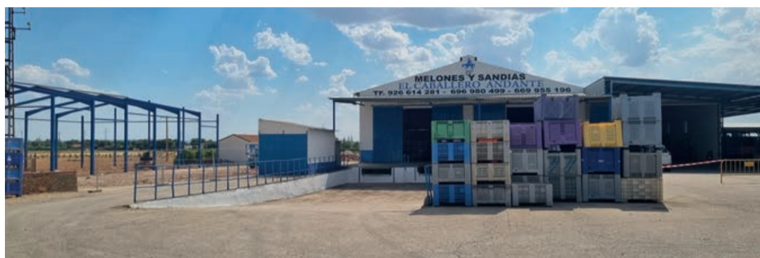
Las obras del nuevo almacén, en el que se instalará la línea para las sandías, ya están en marcha. / NEREA RODRIGUEZ
