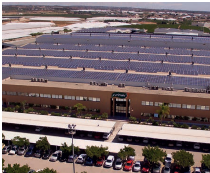
Instalaciones de la cooperativa alicantina Surinver. / UNICA
