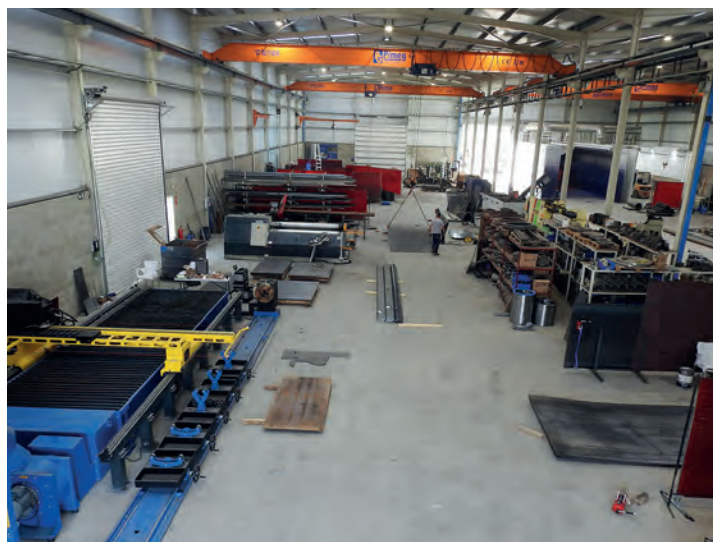
Interior de la nueva nave que acogerá el taller de calderería. / HIDROMATIC
