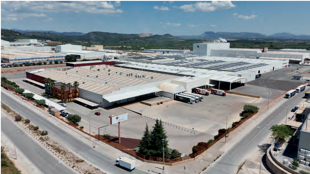
La planta de Onda es actualmente el centro productivo más grande del grupo con más de 66.000 metros cuadrados. / LA PLANA
